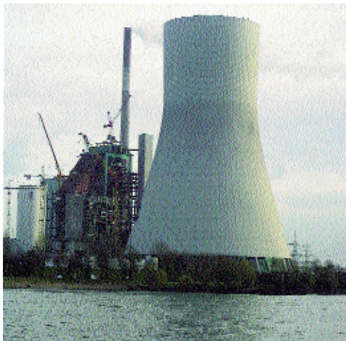
Bild 2. Neubau des Kraftwerks Walsum am Rhein
