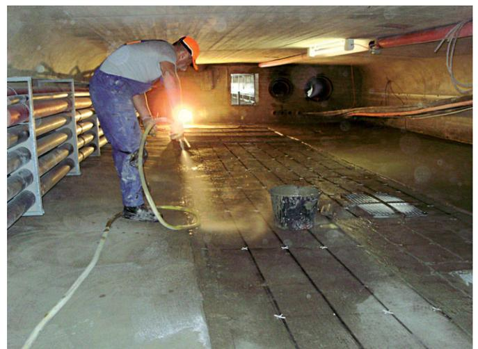
**Bild 2.** Einbau des Einbettmörtels im Hohlkasten (Fotos: Massenberg)
