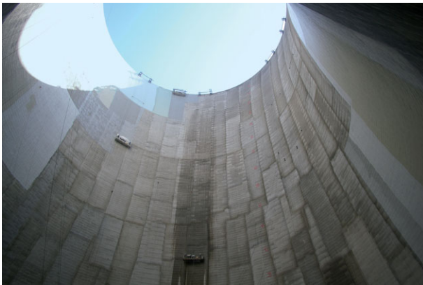
Bild 6. Spritzmörtelarbeiten im Innern eines Kühlturms
