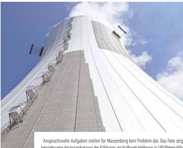
Anspruchsvolle Aufgaben stellen für Massenberg kein Problem dar. Das Foto zeigt beispielsweise die Instandsetzung des Kühlturms am Kraftwerk Heilbronn in 140 Metern Höhe
