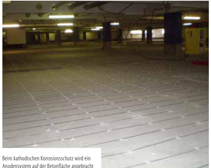
Beim kathodischen Korrosionsschutz wird ein Anodensystem auf der Betonfläche angebracht
