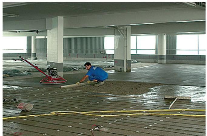
**Bild 3.** Einbettung der Titanbandanode auf einem Parkdeck (Fotos 2 und 3: Massenberg)
