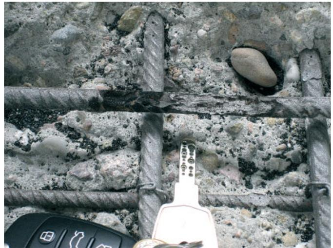
**Bild 2.** Lochfraskorrosion infolge Chlorideintrags
